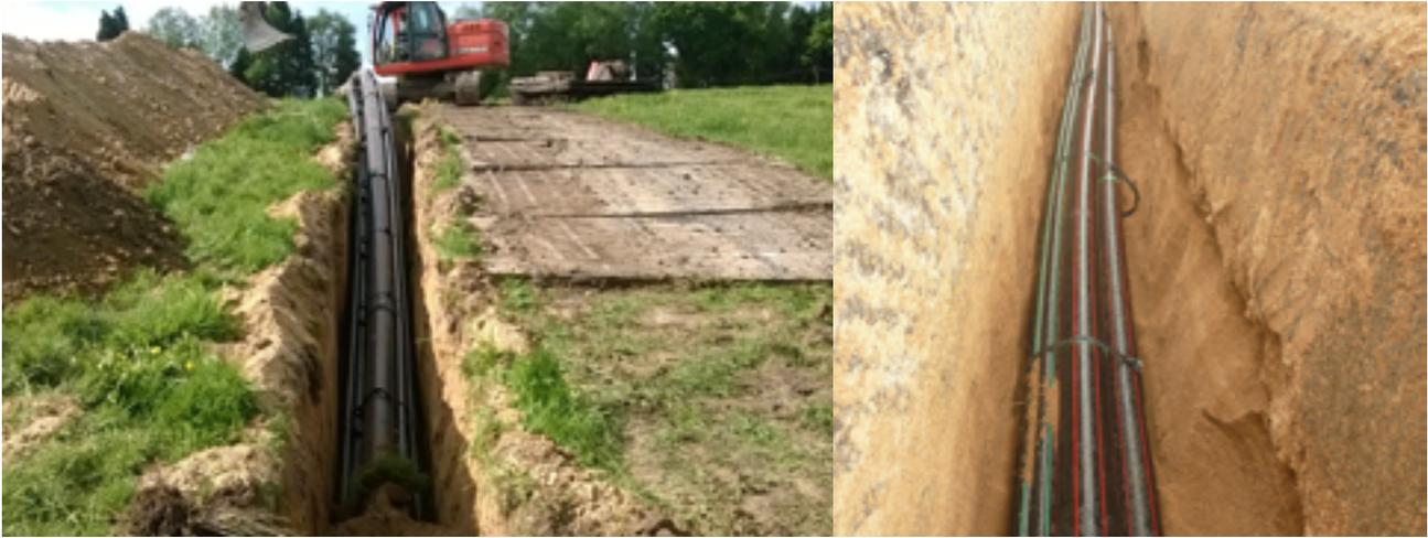
Figure 31 - Pose de câbles souterrains en fourreaux polyéthylène haute densité (PEHD) en zone rurale
