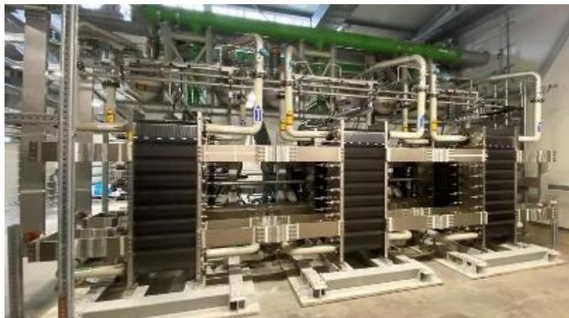
Électrolyseur PEM de Siemens Energy
